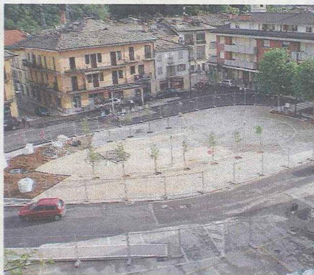
ULTIMATI I LAVORI
